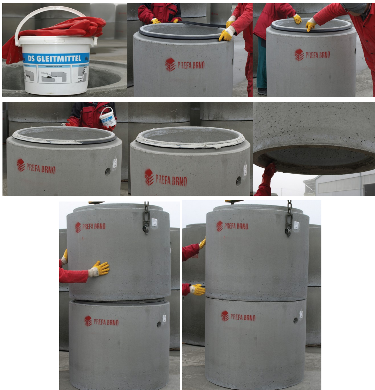
Obr. č.5: montáž skruží s použitím těsnění
