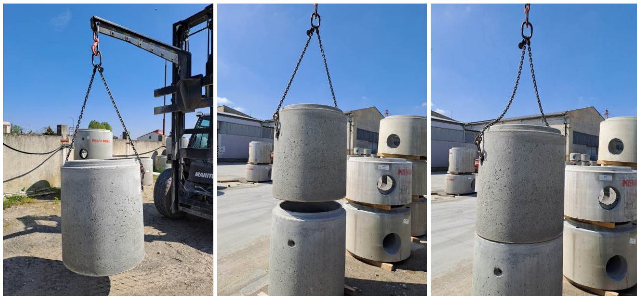
Obr. č.2: montáž skruží bez těsnění
