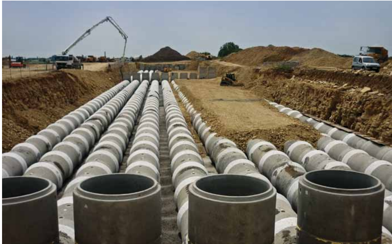
LEGO KLADNO - výstavba retencí v průmyslové zóně Kladno - TZH DN 1200
