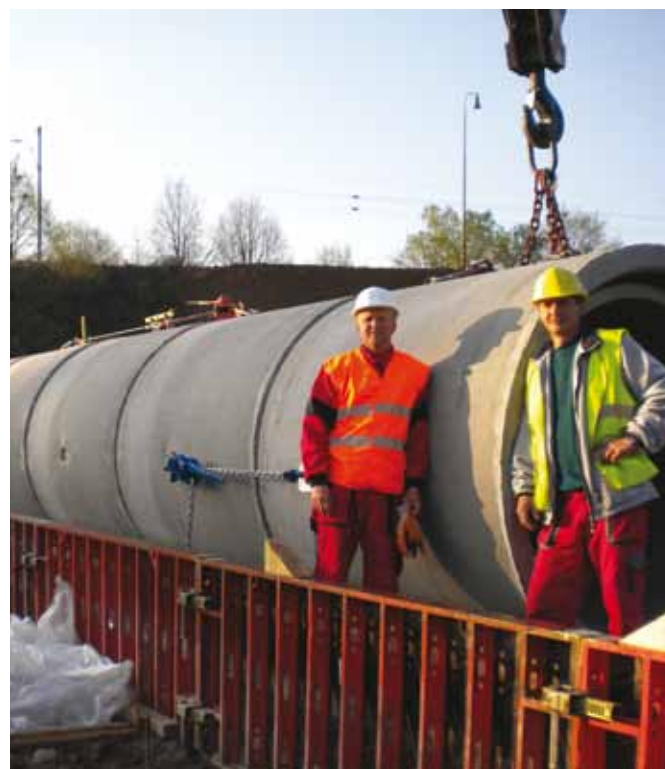
D3 Votice výstavba propustku na D3 - boční montážní DEHA Trouby TZP DN 1600
