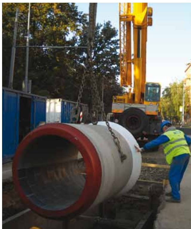
Brno - ulice Pionýrská - rekonstrukce stokové sítě - TZH DN 1200 CV 180
