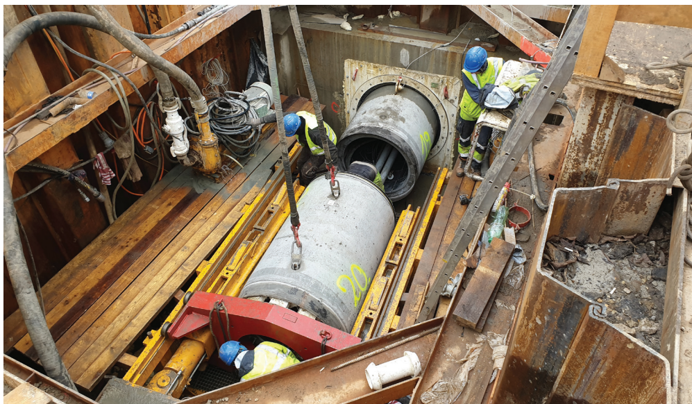
01. Úsilné-Hodějovice - Protlačovací trouby s čedičovou výstelkou
